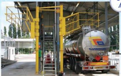
La passerelle abattante permet un accès facile sur le dôme de la citerne depuis un poste fixe. Constituée d'un plancher plat ou à marches, elle assure une sécurité maximale de par son encorbellement positionné autour de la zone de travail.
