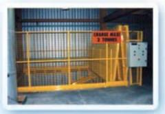
La trappe, en position fermée, constitue un plancher de réception sur lequel l'opérateur peut effectuer ses opérations de manutention En position ouverte, elle assure, en continuité avec les panneaux grillagés, la ceinture complète de la périphérie de la trémie, permettant une protection optimale des opérateurs. L'installation de cet équipement et sa mise en conformité ont été supervisées par la CRAMIF dans toutes les étapes de sa réalisation et de sa mise en place.
